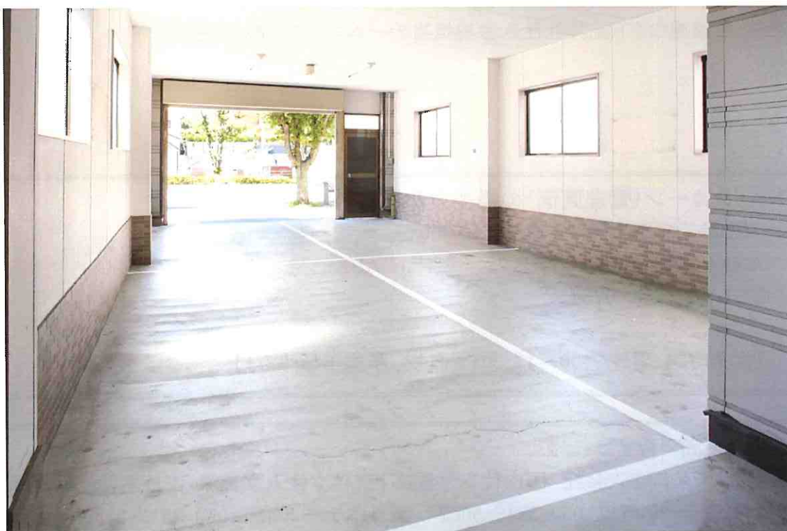
1階駐車場（高さ2.4メートルまで、2トントラック等不可）
